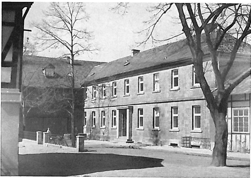
Lehrgebäude des DISEL, Südfront
