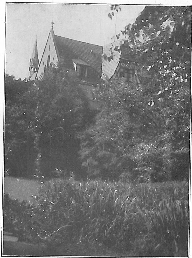
Neubau (vom Park aus).
