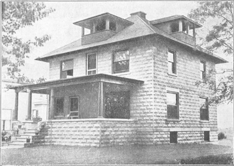
Landhaus aus Beton-Hohlblöcken. (Zu Seite 66.)
