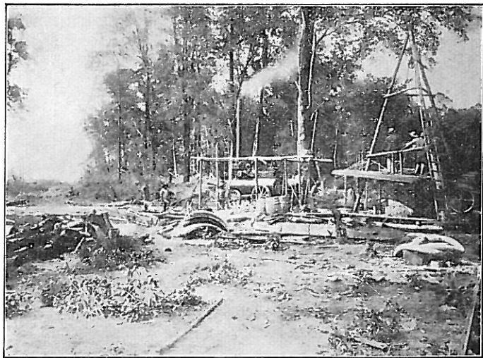
Eine fahrbare Lokomobile im Urwald die eine Pumpenanlage treibt. (1.)
