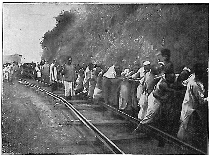
Ueberlandtransport einer 100pferdigen Lokomotive für ein Sägewerk in Ostafrika. (7.)
