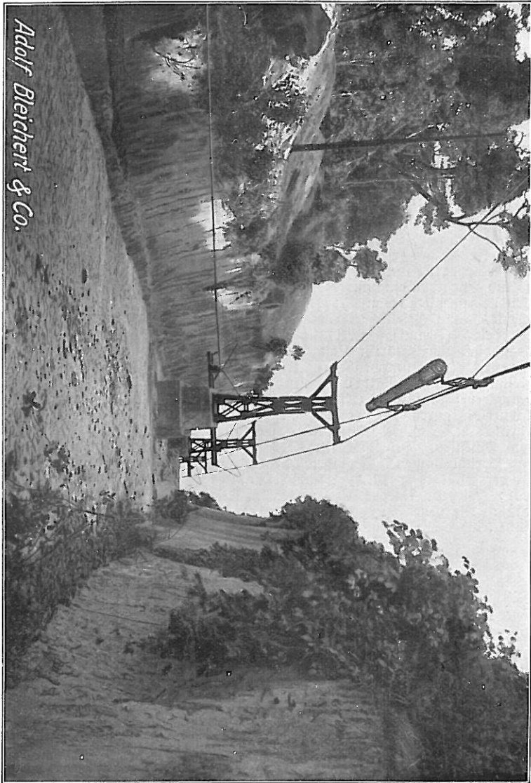
Seilbahn beim Übergang der Seile über den Plateaurand.
